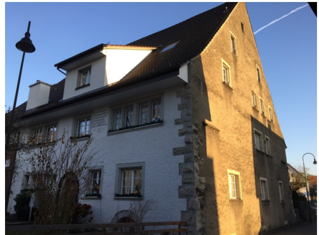
West – und Südfassade
